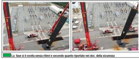
**FASE 3.** Fase di sollevamento e alloggiamento Arpa all'interno della camera fumi. Gli addetti di SkyRope si posizionano sul tetto, in ausilio alle attività di guida dell'Arpa, con il moviere di Autovitor.
