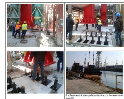
La manovra di imbrigo, sollevamento e posizionamento colonna è stata eseguita correttamente sotto la supervisione dei preposti Termokimik. Il preposto della F.lli Besenzoni era in continuo contatto radio con il grusta della DEMAG TC2800 guidando in modo preciso le manovre di trazione e posizionamento della colonna.
