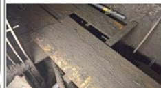
Tramite puntelli, travi e rampe sono stati creati dei piani di lavoro per l'escavatore al fine di mantenere una quota accettabile per poter operare e caricare le carriere poste alla quota del fondo condotta.
