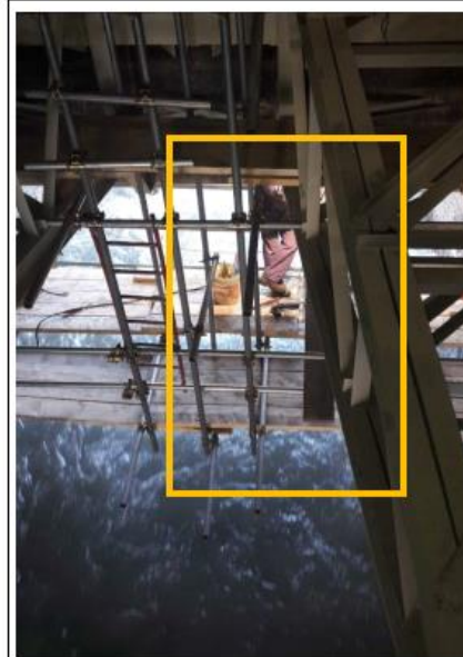
Foto 4 Piani d'appoggio temporanei per escavatore e personale
