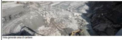
Vista generale area di cantiere
