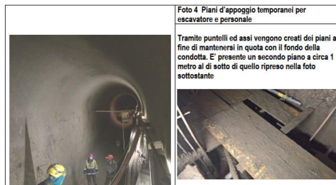
Foto 4 Piani d'appoggio temporanei per escavatore e personale
