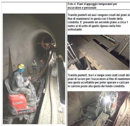
Foto 4 Piani d'appoggio temporanei per escavatore e personale
